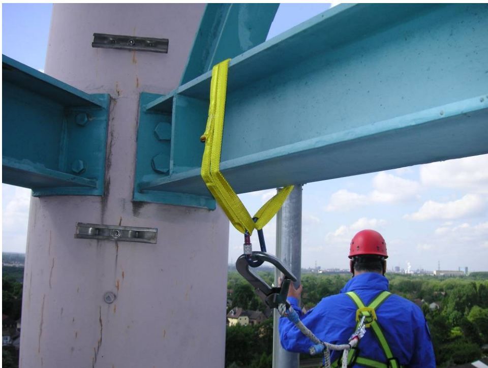
Bild 11: Beispiel für eine Anschlagmöglichkeit am Bauwerk/an einer Konstruktion – Träger, Quelle: DFVG
