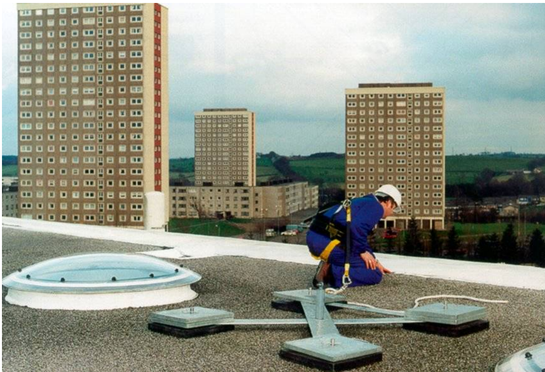
Bild 7: Beispiel für eine temporäre Anschlagereinrichtung auf Eigengewichtsbasis
