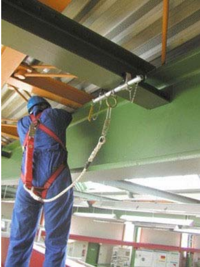
Bild 6: Beispiel für eine temporäre Anschlagereinrichtung – Trägerklemme, Quelle: Fa. BH Sala
